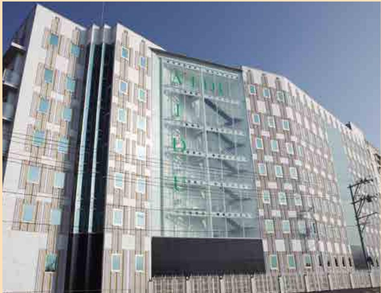
会津本郷焼「流紋焼」の磁器を埋め込み、モダンで個性的な外壁パネル
